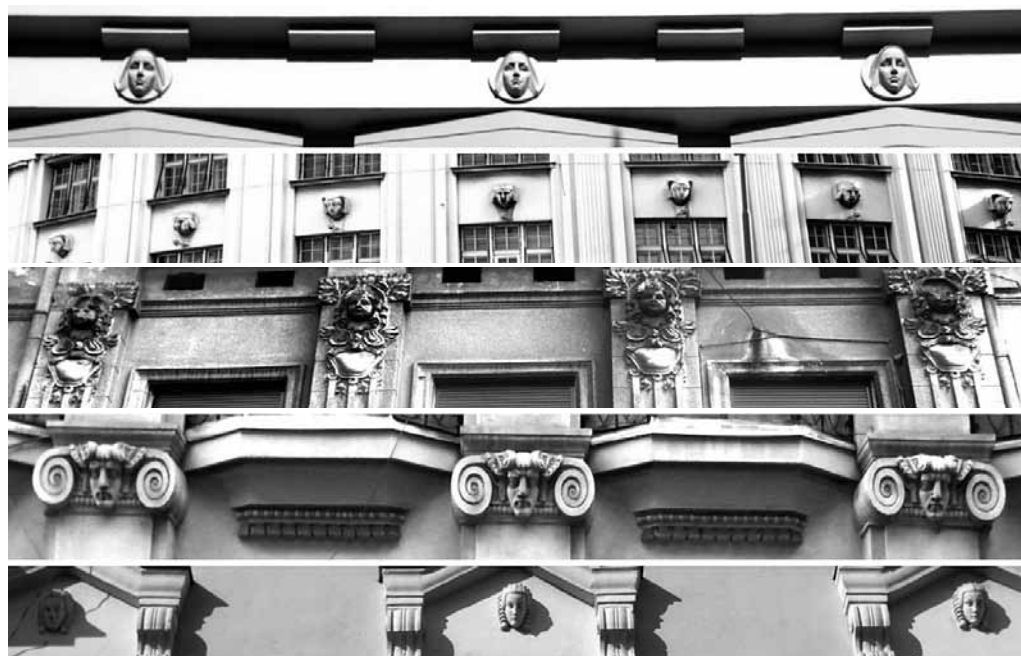
Примери мултиплицирања маскерона на београдским фасадама
